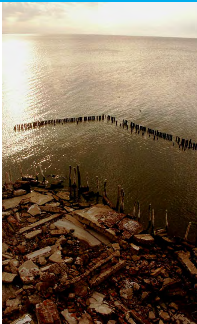
Figura 4. Región costera de Miramar afectada por el aumento de la laguna Mar Chiquita. Pueden verse diferentes protecciones o "empalizadas" efectuados durante el aumento de nivel de la laguna para resguardar las construcciones de la erosión por el oleaje. Foto: E. Piovano.
